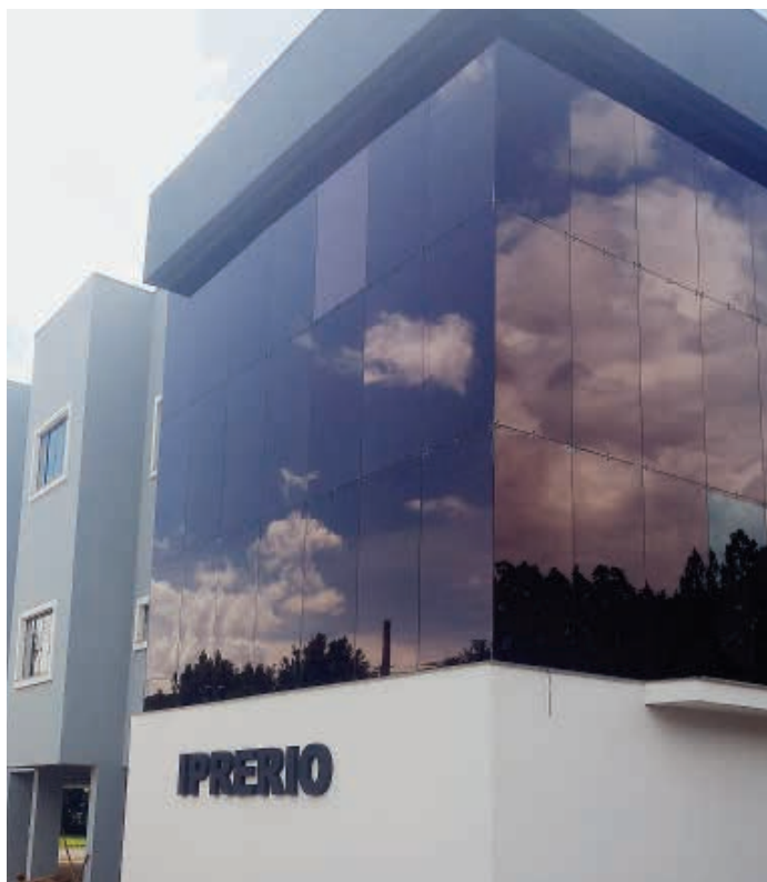
A sede do Instituto é funcional e atende o servidor oferecendo conforto
